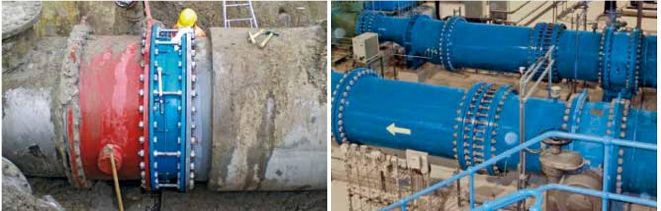
Демонтажные вставки незаменимы при монтаже запорной арматуры и инженерного оборудования на трубопроводах
