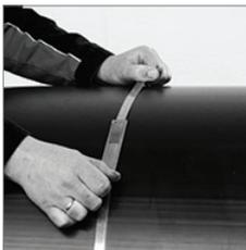
5 При использовании электрофитингов STAR без упора, зона сварки должна быть обозначена при помощи перманентного маркера.
