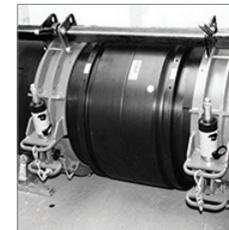
4 При необходимости, примените приспособления для скругления труб. Проверьте измерительной лентой диаметр трубы перед и после процесса снятия оксидного слоя.
