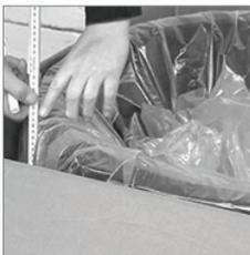
8 Достаньте электромуфту из упаковки, не касаясь зоны сварки, и вставьте в неё конец трубы по маркировочную линию или упор. Перекосы при монтаже не допускаются.
