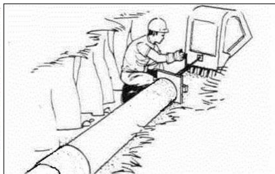
Рисунок Б.10 – Технологические операции монтажа труб «Перфокор» в качестве элемента дренажной системы
